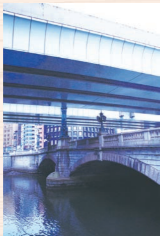
上は高速道路。 下の橋が日本橋です。
